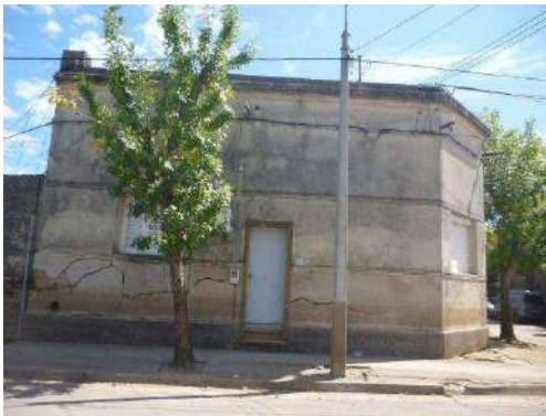
Vivienda Sector D_ Grietas en muros
