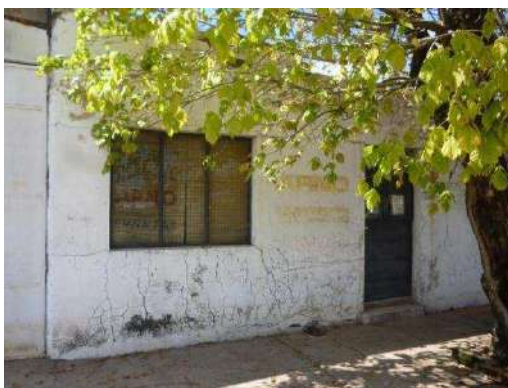
Vivienda Sector C_ Grietas en muros
